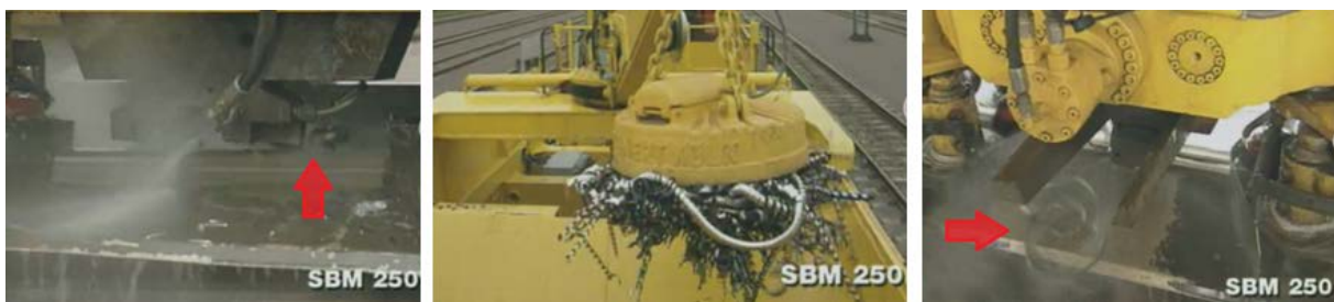
Abbildung 42: Schienenhobeln am Beispiel der Plasser & Theurer Maschine SBM 250 [50]
