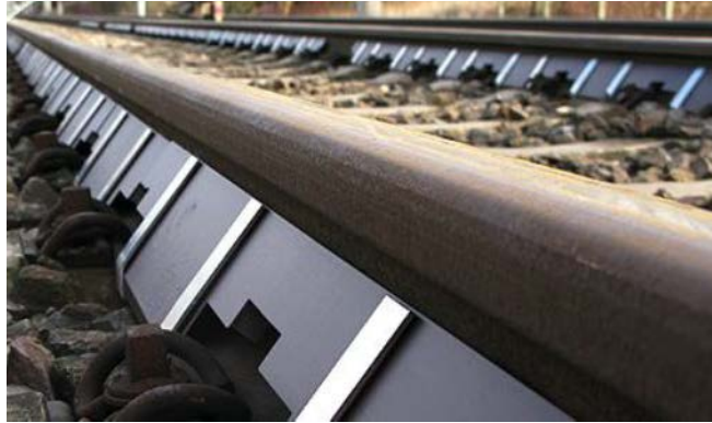
Abbildung 6: Schienenstegabschirmung [18]
