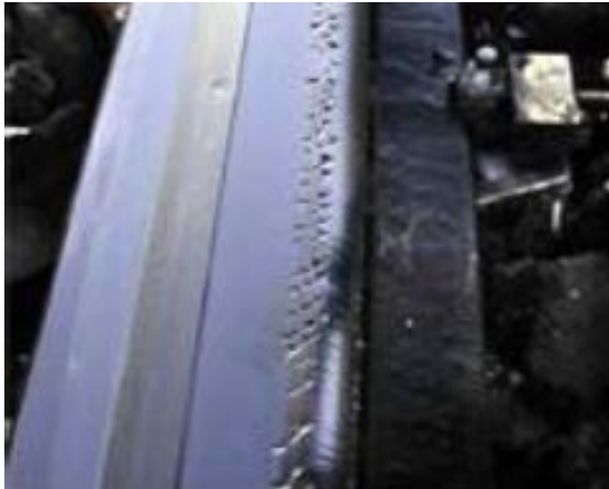
Abbildung 43: Schienenoberfläche nach Schienenbearbeitung mit Hobelmaschine [49]
