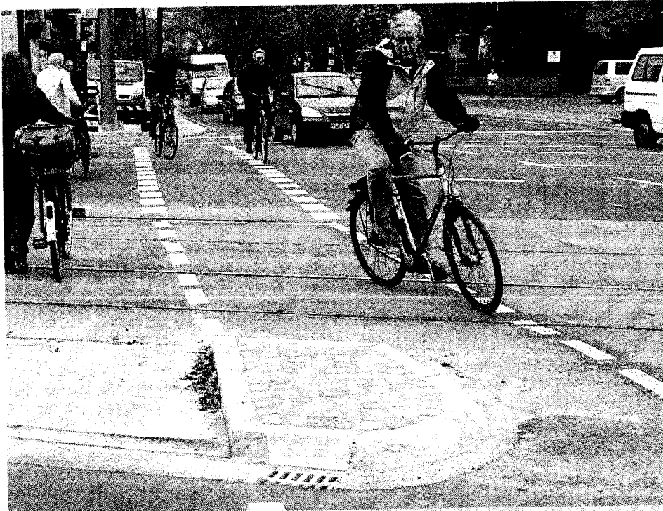
Achtung, Sturzgefahr: In die Radfahrer-Furt auf der Schwachhauser Heerstraße ragt eine hochgeplasterte Mittelinsel. Der ADFC hält das für lebensgefährlich. FOTO: FRANK THOMAS KOCH
