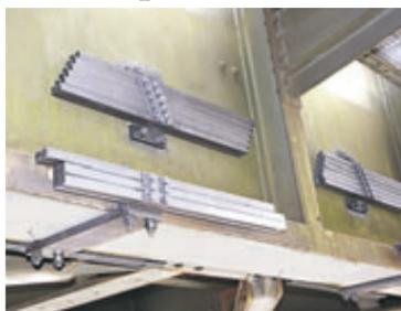
Sogenannte Brückenabsorber werden an den Teilen einer Brücke befestigt, die besonders stark schwingen. Das „Brückendröhnen“, das entsteht, wenn ein Zug passiert, wird dadurch vermindert.
