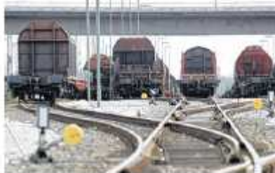
Um den stetig wachsenden Güterumschlag zu bewältigen und Engpässe zu vermeiden, sollen in den kommenden Jahren insgesamt 35 Millionen Euro in die Bremische Hafeneisenbahn investiert werden.
