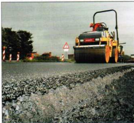
Straßenlärm halbiert Neuer Flüsterasphalt auf der Autobahn bei Osnabrück
