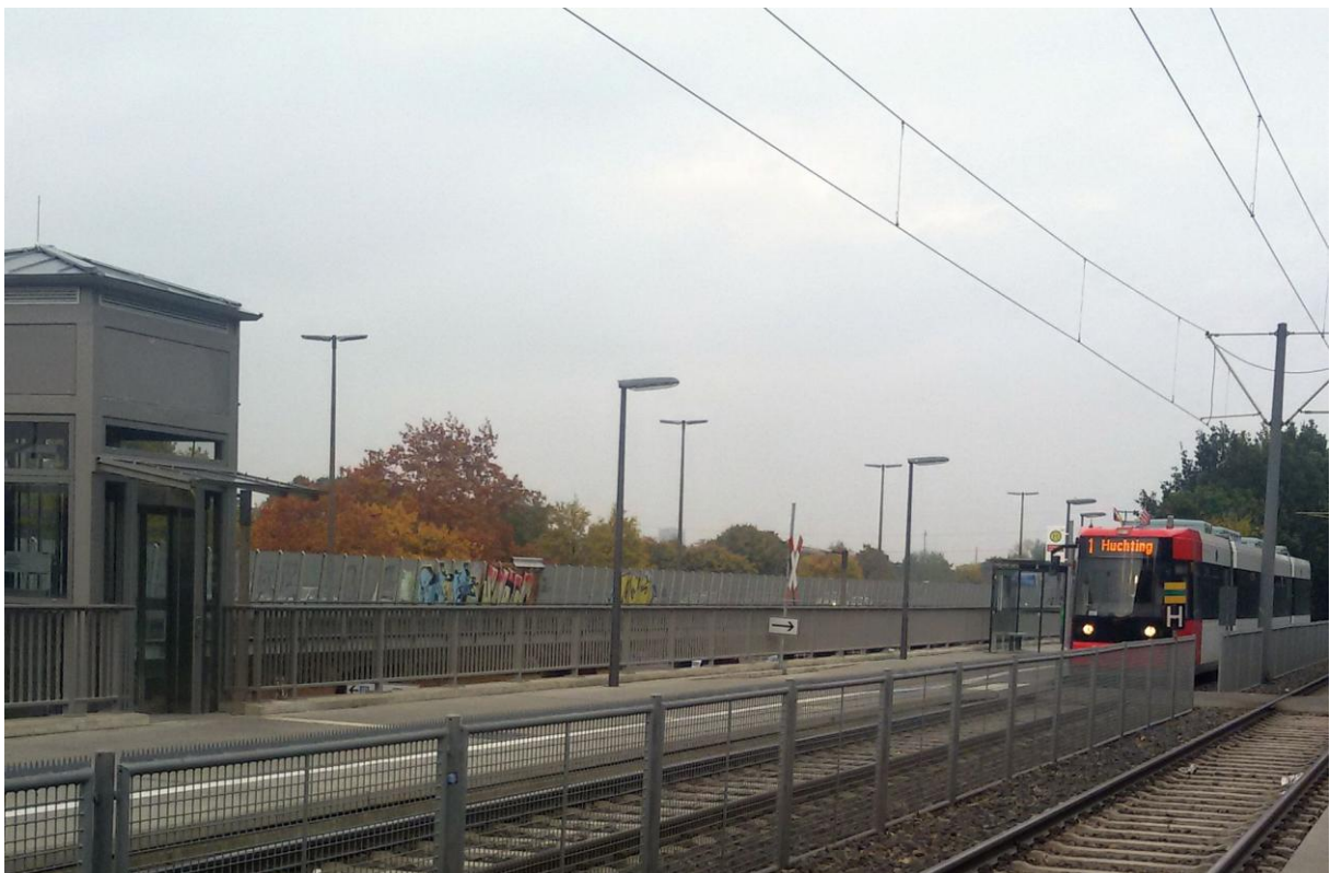
Die Haltestelle Norderländer Straße erhielt bei ihrer Sanierung ein offenes, freundliches Bild. Die neuen Glaswartehäuschen vermitteln den Fahrgästen auch in der dunklen Jahreszeit durch ihre Transparenz und gute Beleuchtung nun kein Angstgefühl mehr, denn sie sind auch von der tiefer liegenden Straßenebene einsehbar. Die barrierefreie Erreichbarkeit der Bahnsteige wird durch einen Fahrstuhl gewährleistet.
