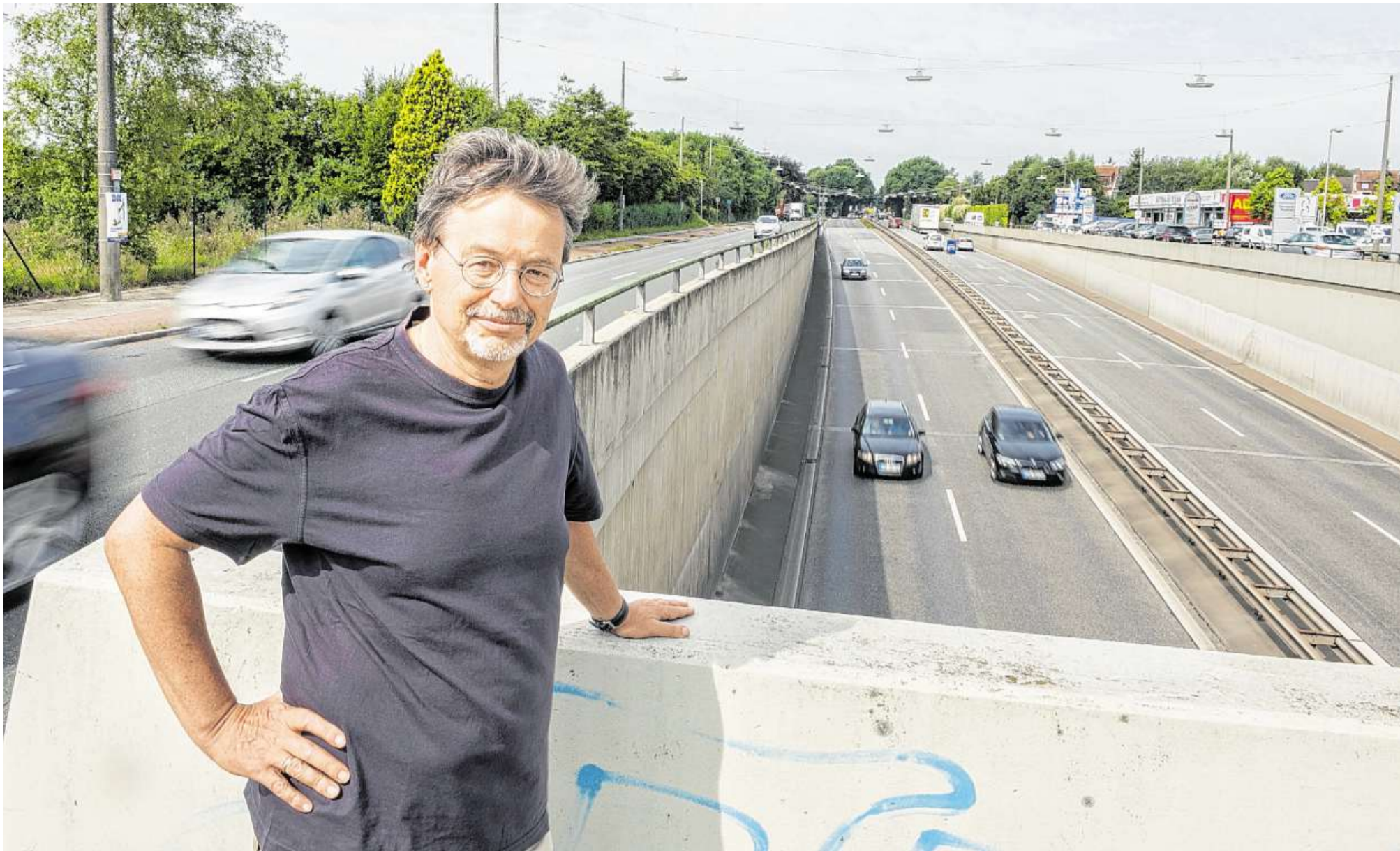
Norbert Breeger von der Vereinigung der Bürgerinitiativen A 281 steht über dem vierspurigen Tunnel zwischen der Neuenlander Straße und dem Autobahnzubringer Arsten.
