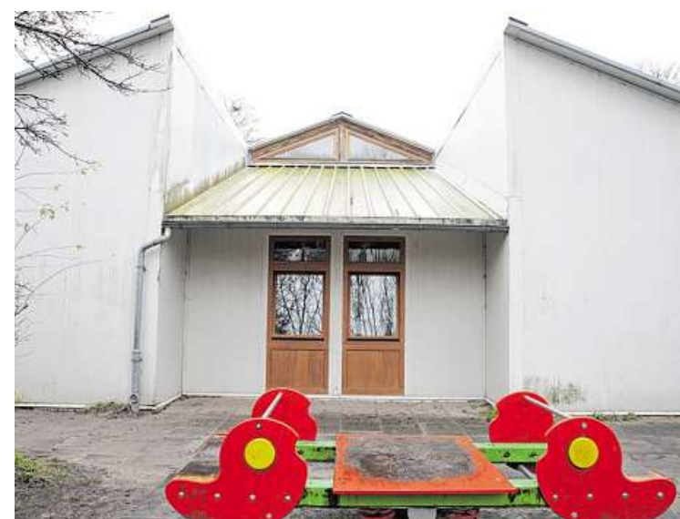
Das Horthaus an der Dresdener Straße soll im nächsten Jahr abgerissen werden. FOTO: SCHEITZ
