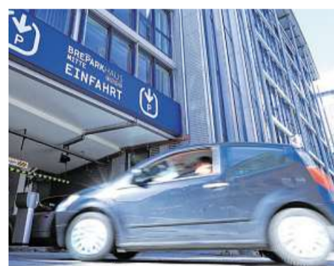
Einfahrt zum Parkhaus Mitte, das abgerissen werden soll. FOTO: FRANK THOMAS KOCH
