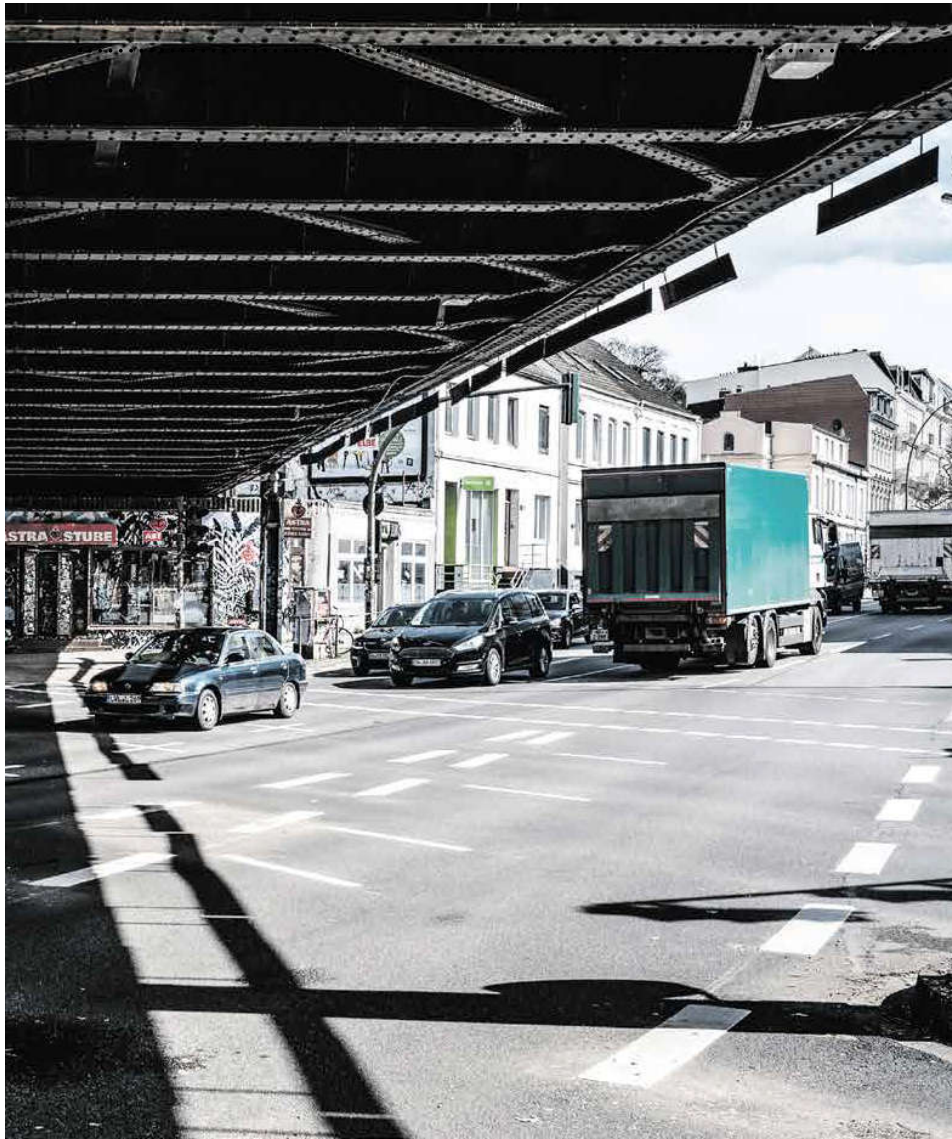
Unter der Sternbrücke, über die die Züge fahren, hausen die Klubs an der Stresemannstraße – doch ihre Tage sind gezählt: Die Brücke wird neu gebaut Foto: Miguel Ferraz
