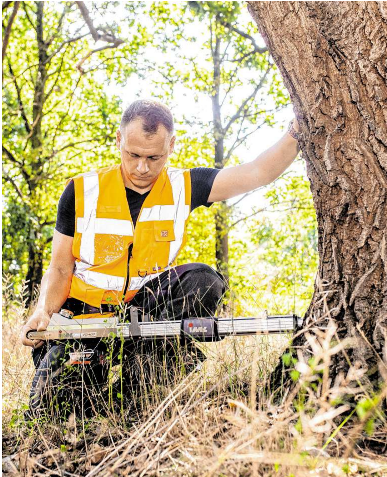
Steffen Kobrig prüft mit einem Resistographen, ob diese Eiche von innen hohl ist. Ist das mit mehr als zwei Dritteln der Fall, wird der Baum abgesägt, damit er nicht auf das Gleis fällt. Die Deutsche Bahn sucht noch weitere Baumkontrolleure wie Kobrig. FOTO: JONAS KAKO
