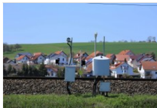
Durch das im Jahr 2019 installierte Lärmmonitoring an stark befahrenen Bahnstrecken ...
