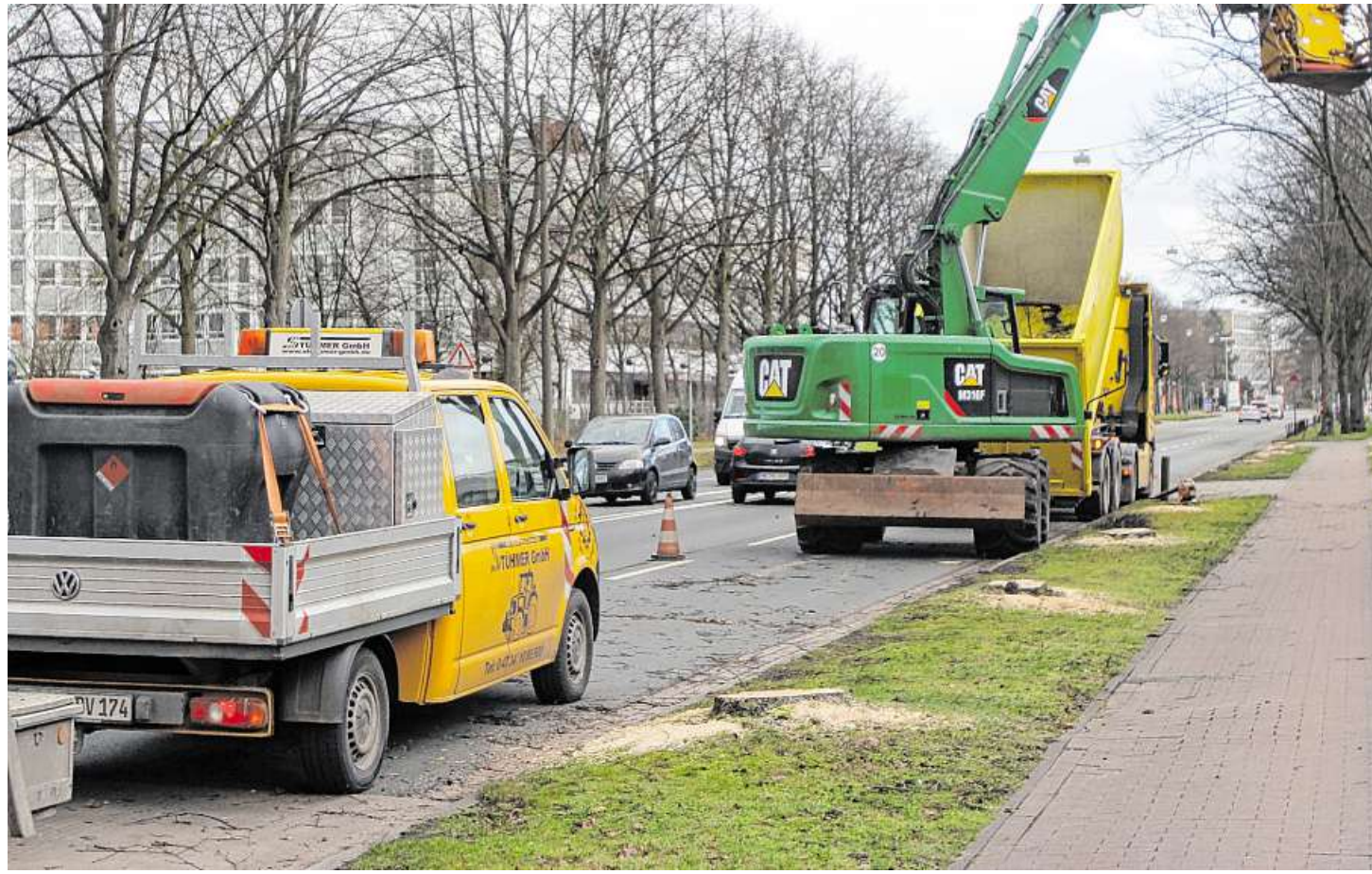
Mit schwerem Gerät kappten die Facharbeiter die Bäume entlang der Stresemannstraße.
