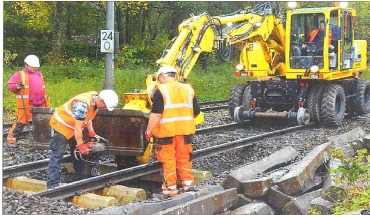
Mit einem Zweibegebagger holten Mitarbeiter eines Gleisbauunternehmens die zerstörten Betonschwellen aus dem Gleisbett und ersetzten sie durch neue. BILD: KARSTEN KOLLOGE
