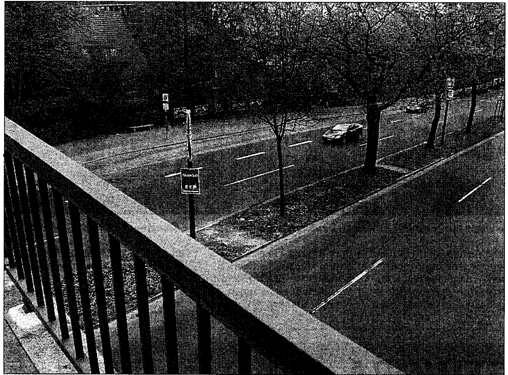
Trampelpfade von der Kelbraer Brücke aus gesehen. Sie zeigen, dass Passanten die Kurfürstenallee überqueren, ohne die Brücke zu nutzen. Foto: Joswig
