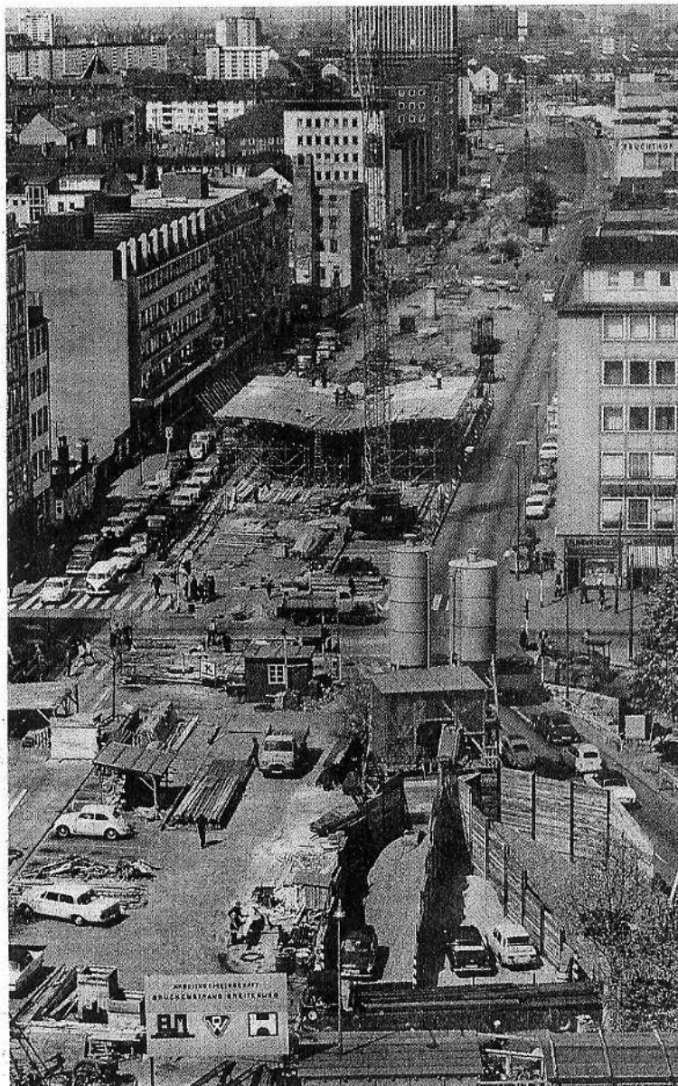
Ein Bild aus der Zeit, als sich die Hochstraße, die damals als ein architektonisches Vorzeige-Projekt gehandelt wurde, noch im Bau befand. FOTO: HINRICH MEYER
