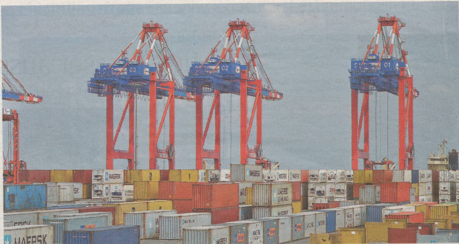
Jade-Weser-Port Wilhelmshaven: Allein der Wind sorgt für Bewegung.
