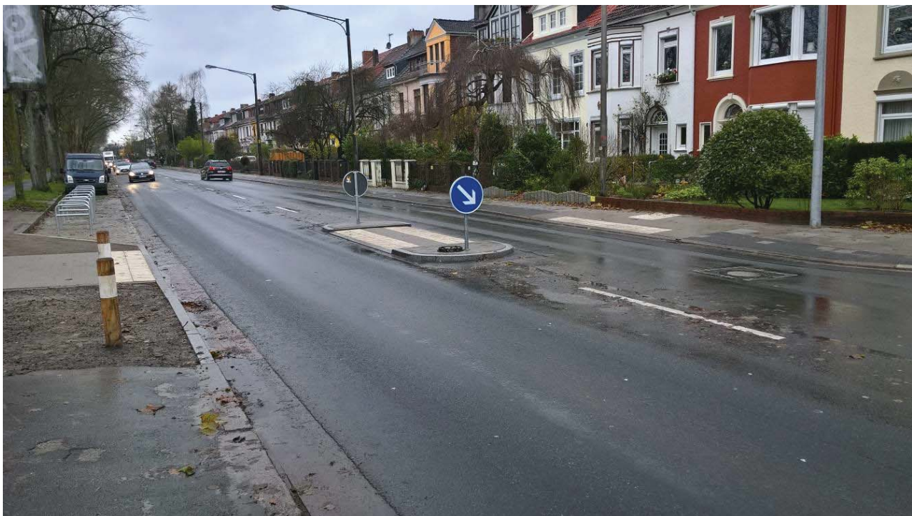
Abbildung 2-6 Neue Querungshilfe am Osterdeich; Quelle: Amt für Straßen und Verkehr
