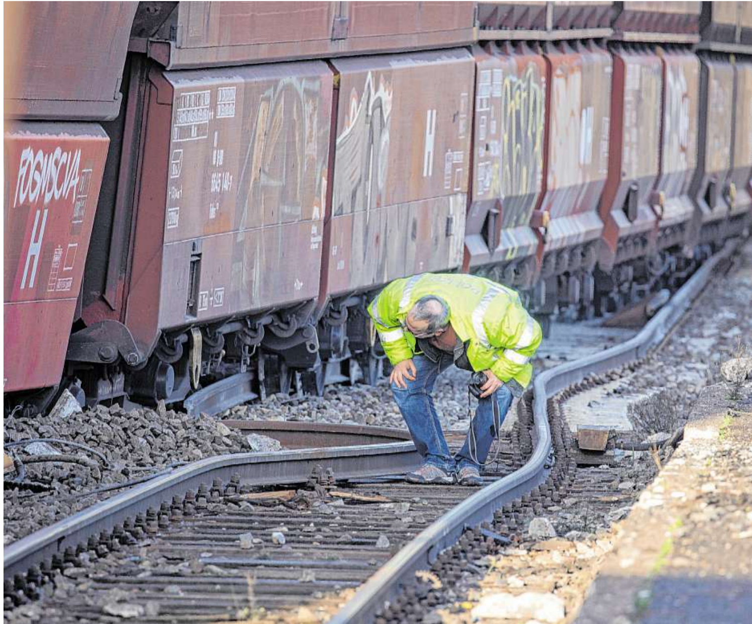
Der entgleiste Güterzug am Bahnhof Bremen-Neustadt hat für erhebliche Schäden gesorgt.
