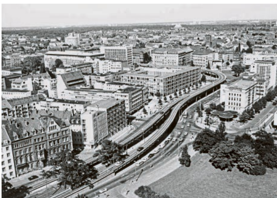
Hochstraße über dem Aegidientorplatz in Hannover
