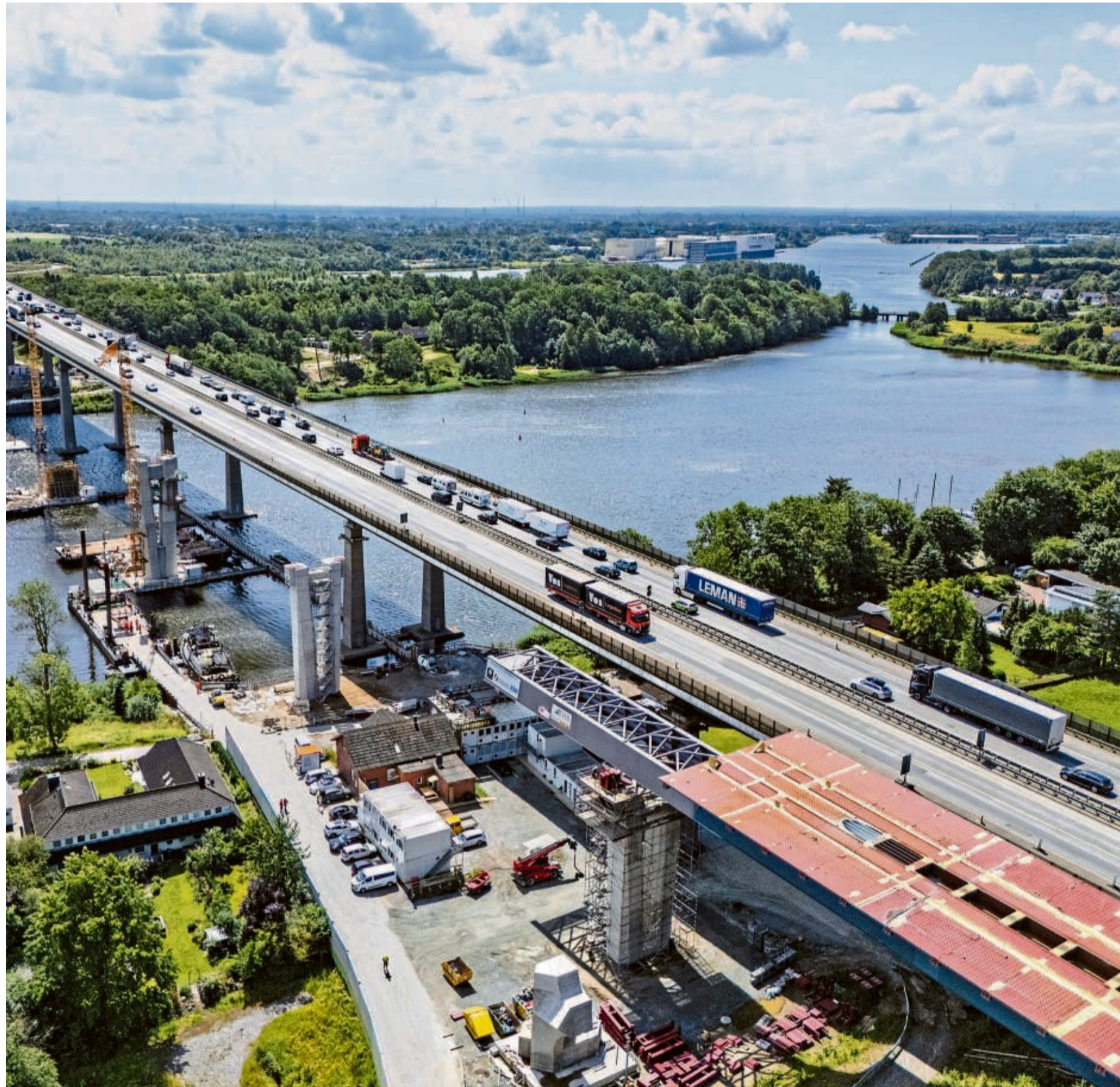
Brückenbau: Zur Finanzierung von Investitionen in die Straßen-Infrastruktur empfiehlt der Sachverständigenrat Wirtschaft eine Pkw-Maut
