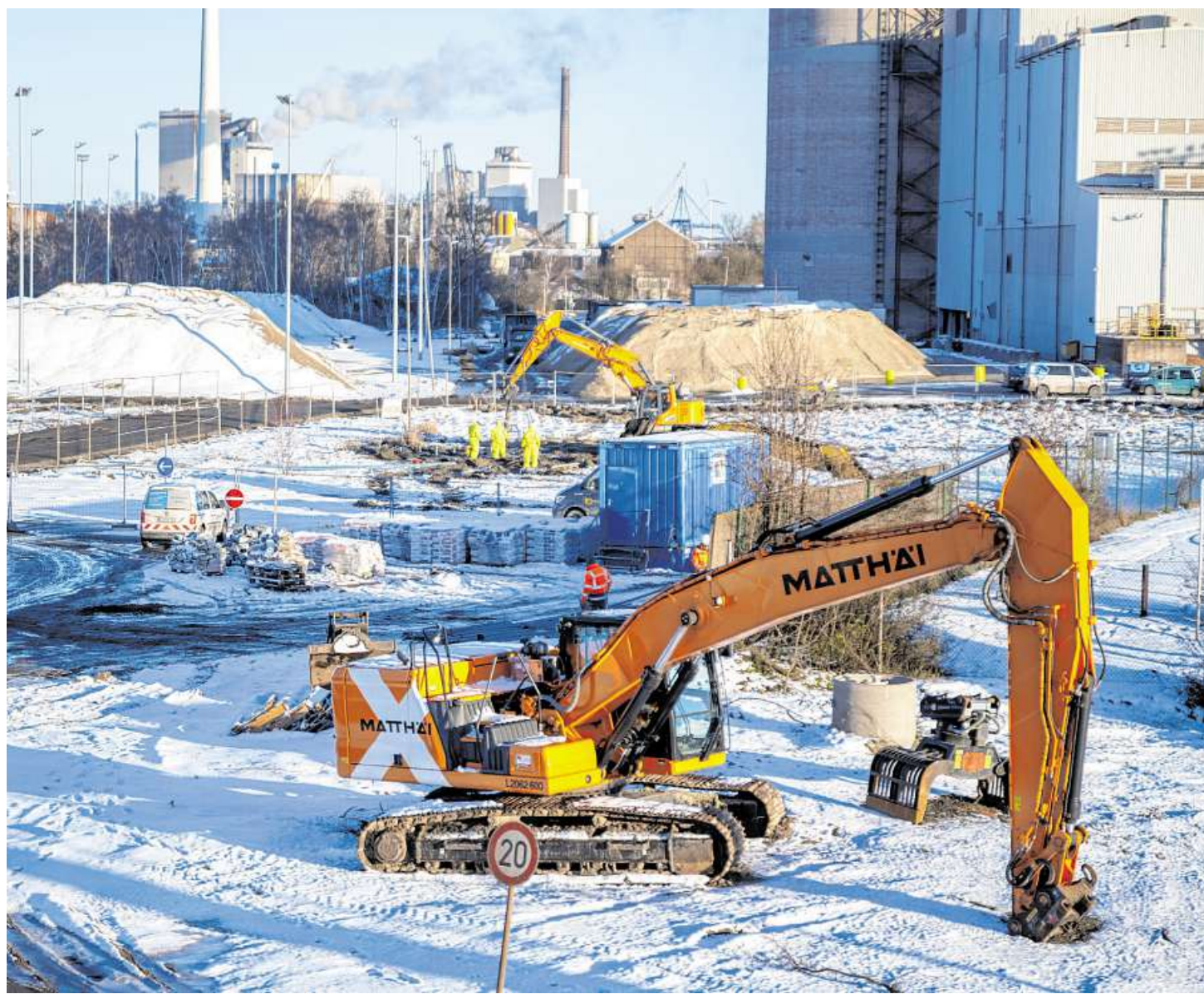
Vom Tunnel ist noch nichts zu sehen, aber auf der Nordseite der zukünftigen Weserquerung gehen die vorbereitenden Arbeiten sichtbar voran. Die aufwendige Kampfmittelsondierung ist eine von vielen Aufgaben. FOTOS: CHRISTINA KUHAUPT
