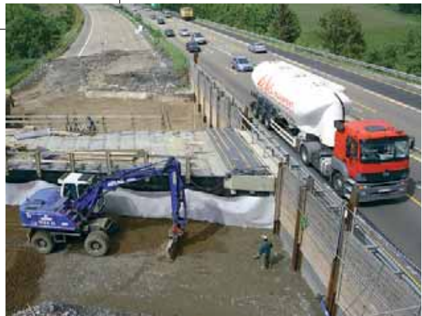
Erneuerung eines Brückenbauwerks
